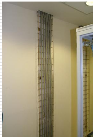
Опуск кабеля к 19" стойке
