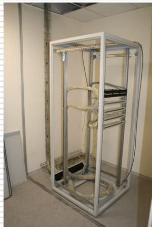
Монтаж 19" стойки
